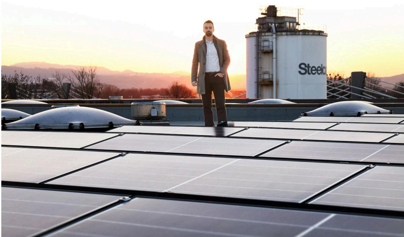
**« Les panneaux solaires couvrent une surface de 250 m<sup>2</sup> et génèrent 30 000 kWh d'électricité par an. En association avec la chaudière à cogénération, ils permettent de produire près de 50 % des besoins en électricité de l'usine en hiver. »**
