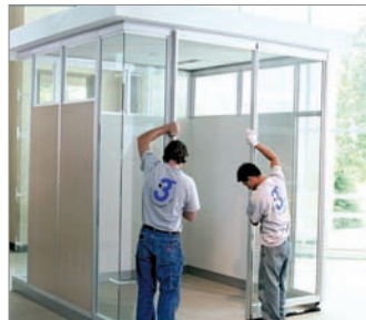
6. Install door frame
